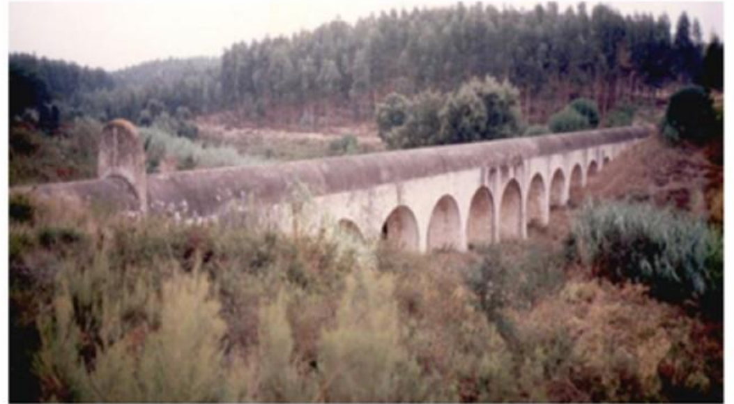
Aqueduto do Alviela
